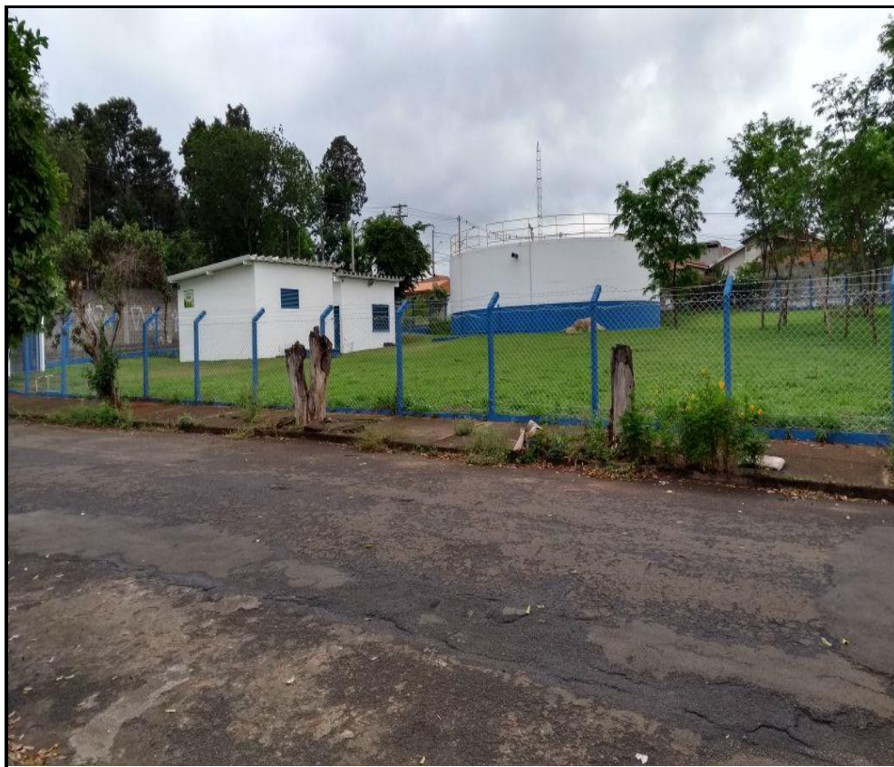
Figura 28 - Reservatório Santa Luiza
