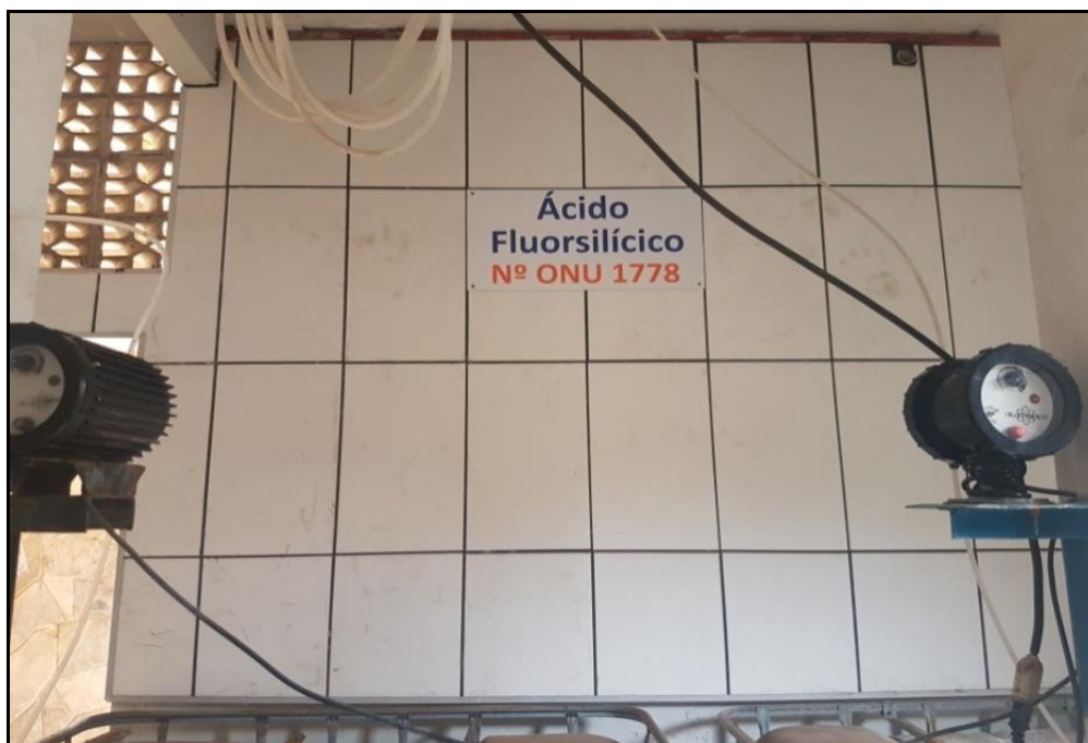
Figura 17 - Dosador de Ácido fluossilícico
