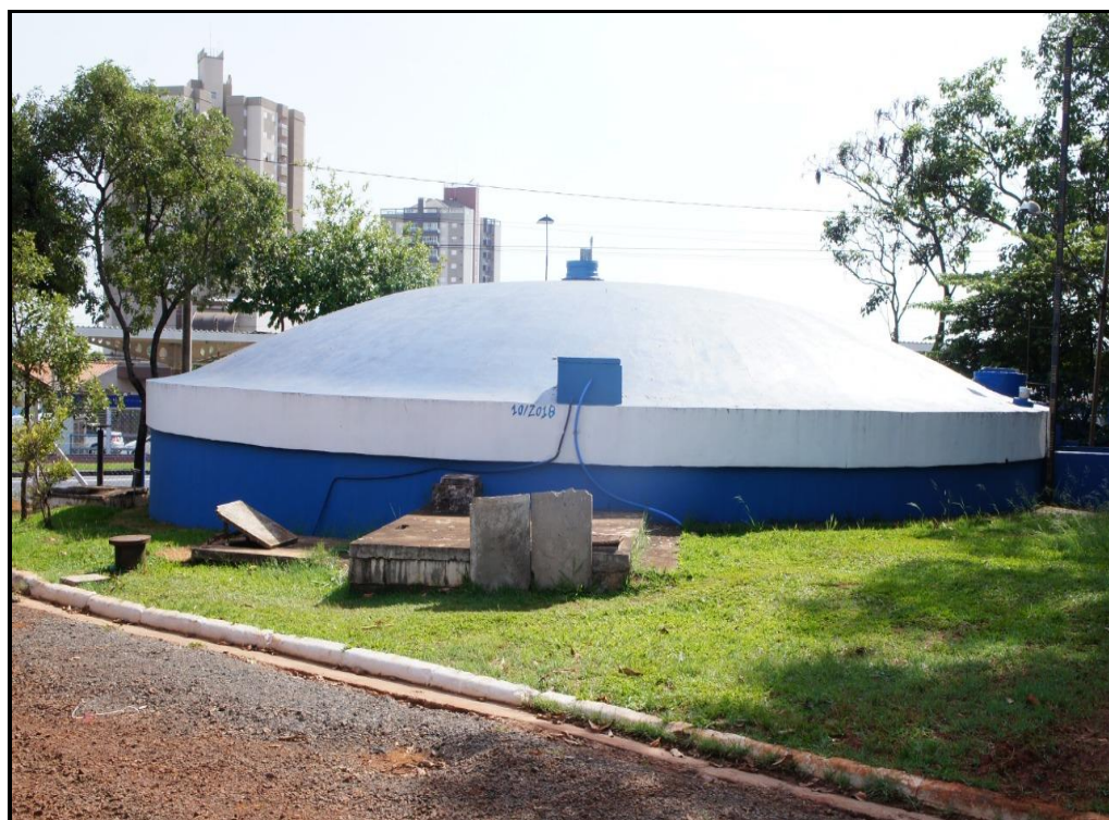
Figura 24 - Reservatório semi enterrado - 1.000 m 3
