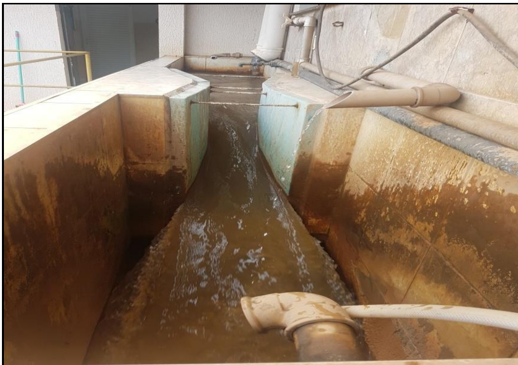
Figura 10 - Vertedor Parshall – Mistura Rápida
