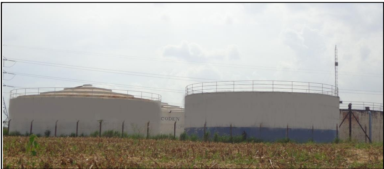
Figura 26 - Centro de reservação Klavin
